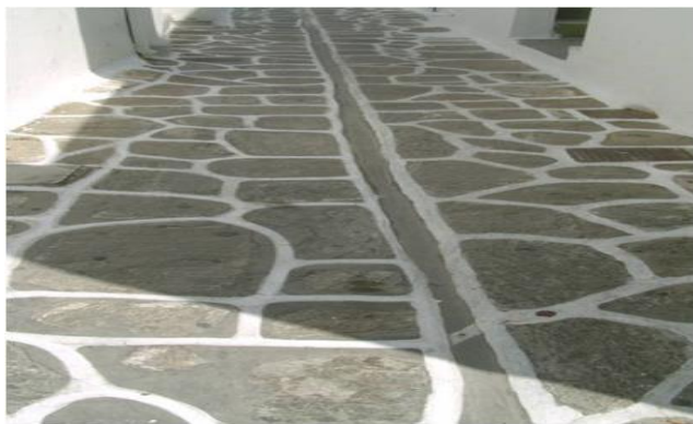
Εικόνα 7. Παροικία Πάρου. Πλακόστρωτος δρόμος με δυνατότητα απορροής ομβρίων στον άξονα του (φωτ. Αύγουστος 2008).
