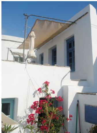
Εικόνα 17. Διώροφη οικία στα Δυό Χωριά Τήνου με ανεξάρτητες προσβάσεις σε κάθε όροφο (φωτ. Αύγουστος 2010).
