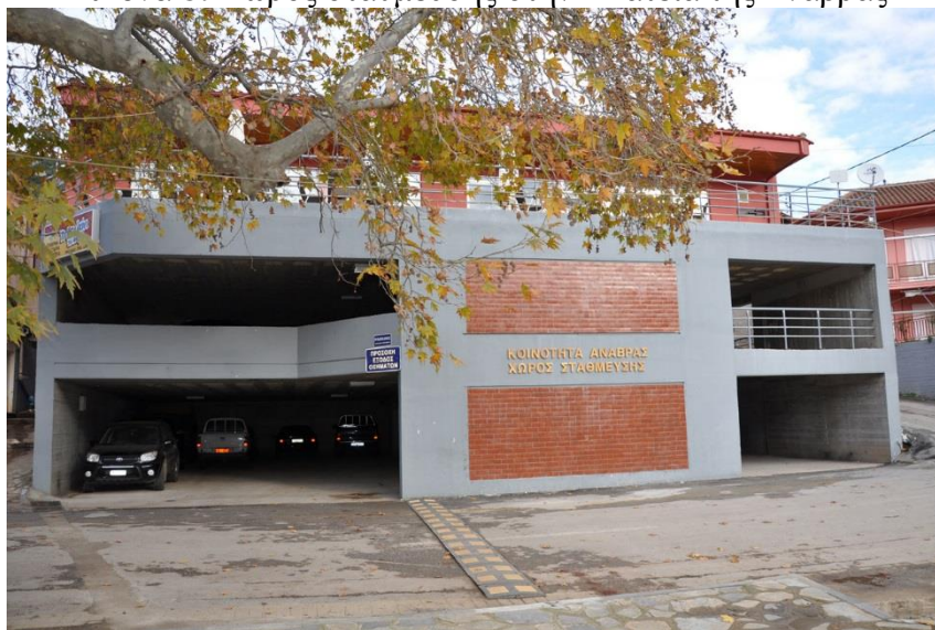
Εικόνα 8: Χώρος στάθμευσης στην Πλατεία της Ανάβρας
