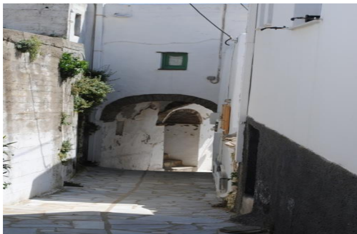
Εικόνα 9. Δύο Χωριά Τήνου. Γεφυρωτή κατασκευή δεσπόζει στο οδικό πέρασμα του μικρού
