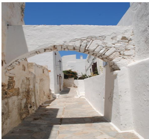
Εικόνα 8. Χώρα Νάξου. Τόξο αντιστήριξης απέναντι κτηρίων (φωτ. Ιούλιος 2012)
